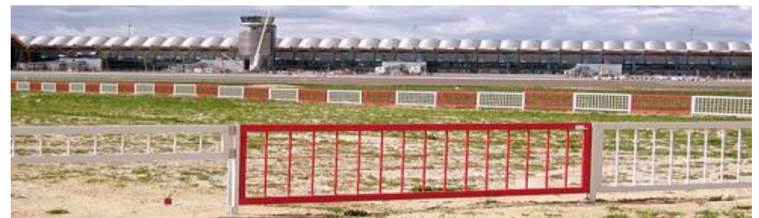
Cerramiento zonas ILS de SPM. Aeropuerto Adolfo Suarez Madrid - Barajas. T4
